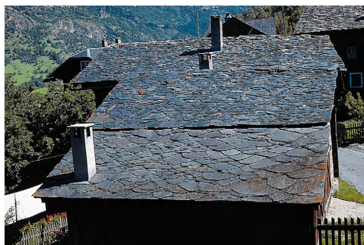
Abbildung 6.44: Schieferdach aus einheimischem dunklem Kalkschiefer in Termen VS.
