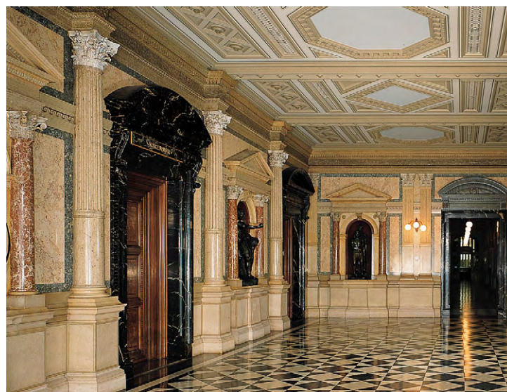
Abbildung 6.10: Vorraum des Bundesratszimmers im 1. Stock des Bundeshaus Ost in Bern. Türgewände: Algenkalkstein von Ragaz; grosse Säulen: Solothurnerstein; Sockel: Portlandkalkstein von
