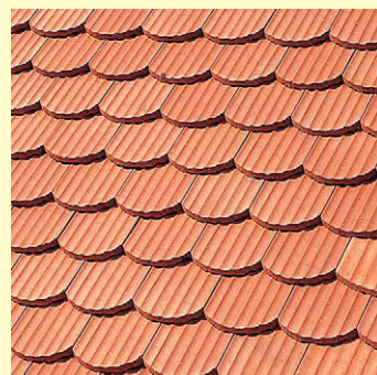
Bedachung mit Biberschwanzziegel
