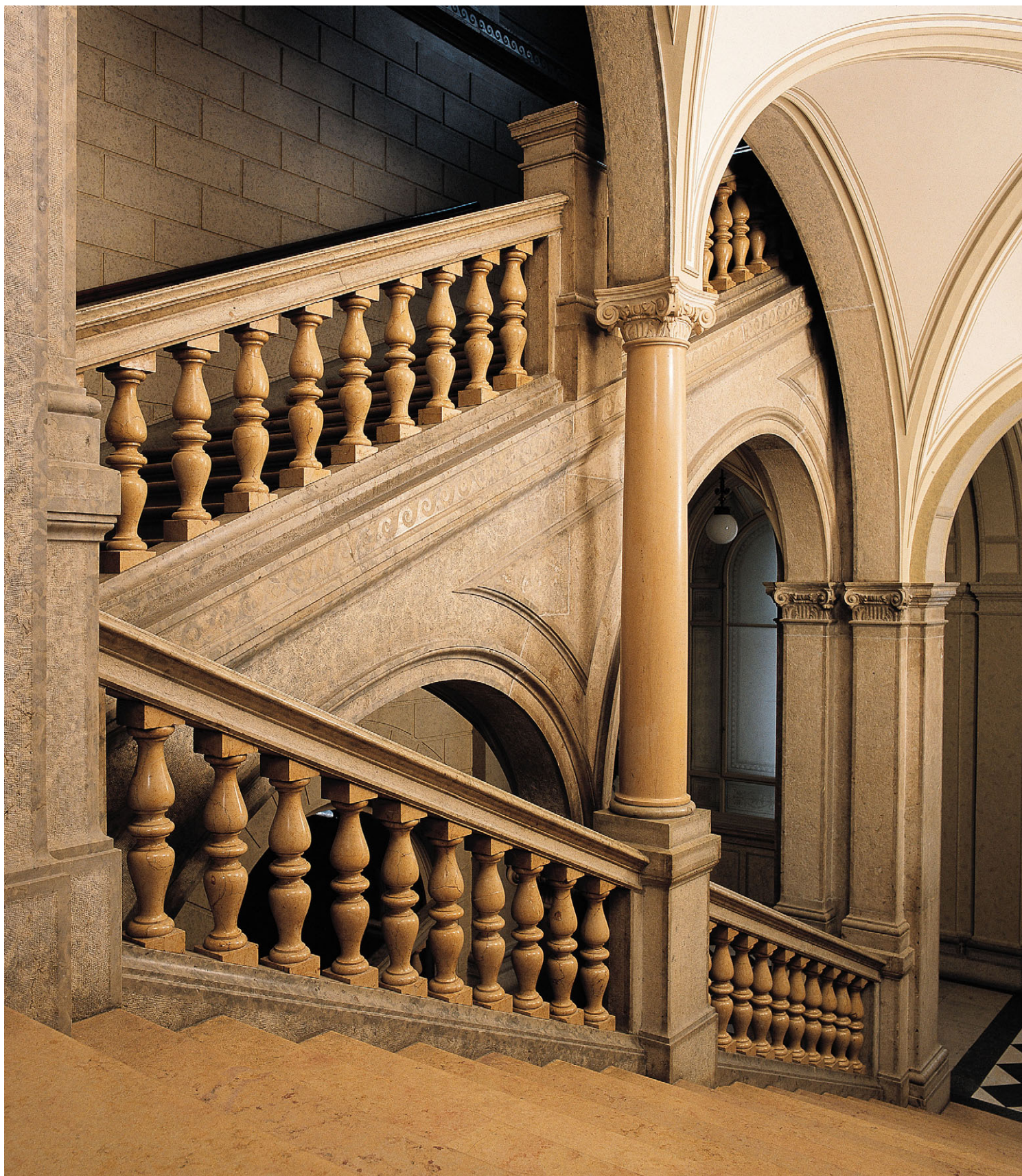
Abbildung 6.17: Treppenhaus aus gelben Kalksteinen im Bundeshaus Ost in Bern. Es dominiert der Solothurnerstein. Ausnahmen bilden die Säule in der Bildmitte (Plattenkalk des Portlandien von
